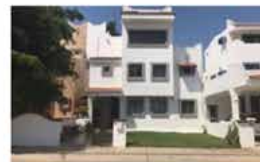
Fraccionamiento cerro del vigia
