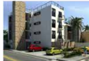
Proyecto residencial fraccionamiento playa sur
